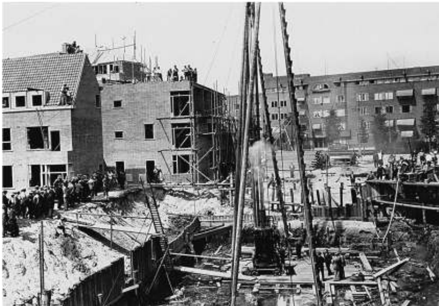
Afbeelding 11: Heien met behulp van een stoomheiblok op het Daniël Willinkplein (tegenwoordig Victorieplein) ca juli 1930 (Stadsarchief Amsterdam)
