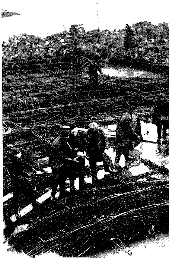
FIG. 3 A willow mattress being sunk. (Kees Slager, De Ramp: Een reconstructie [Goes, 1992].)
